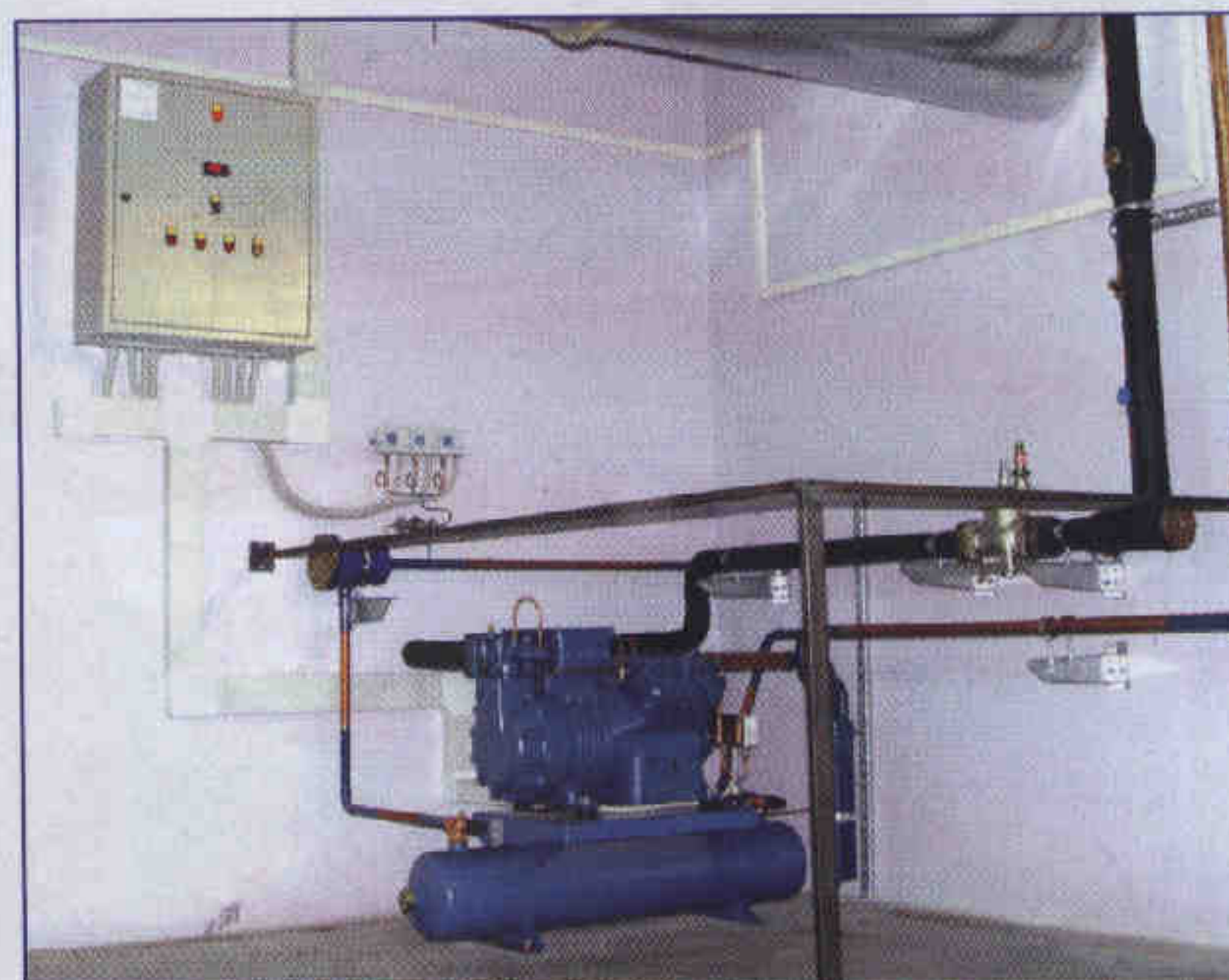
Компрессорно-ресиверный агрегат компании «ТЕКО»
