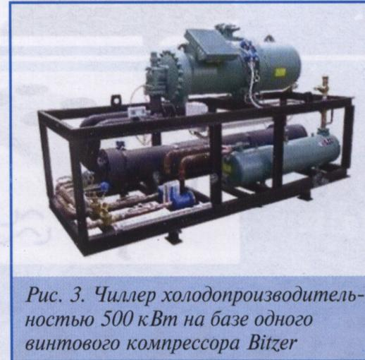
Рис. 3. Чиллер холодопроизводительностью 500 кВт на базе одного винтового компрессора Bitzer
