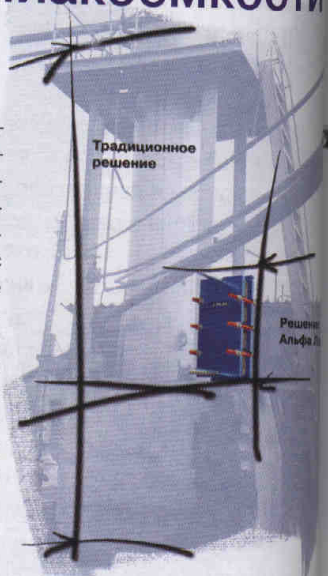
Относительные габариты аммиачных конденсаторов: используемого ранее и нового пластинчатого фирмы «Альфа Лаваль»
