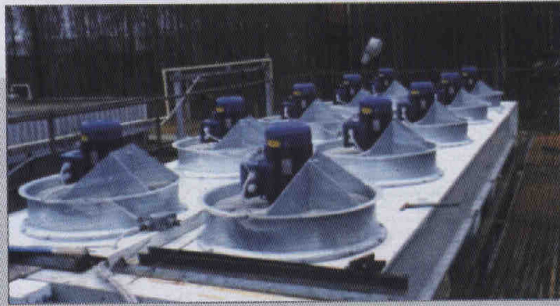
Рис. 2. Воздушный конденсатор с автоматически регулируемым теплоотводом фирмы Alfa Laval
