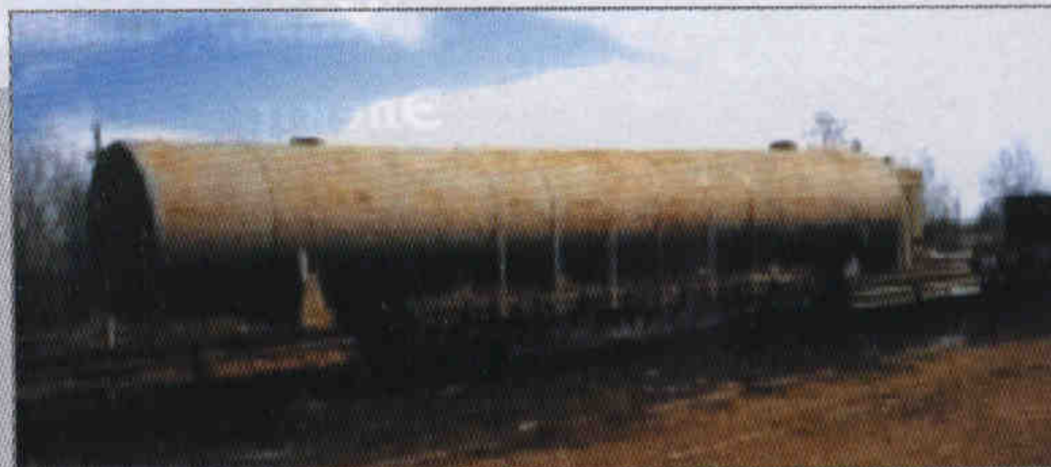
Рис. 4. Система хранения на базе стационарного криогенного резервуара
