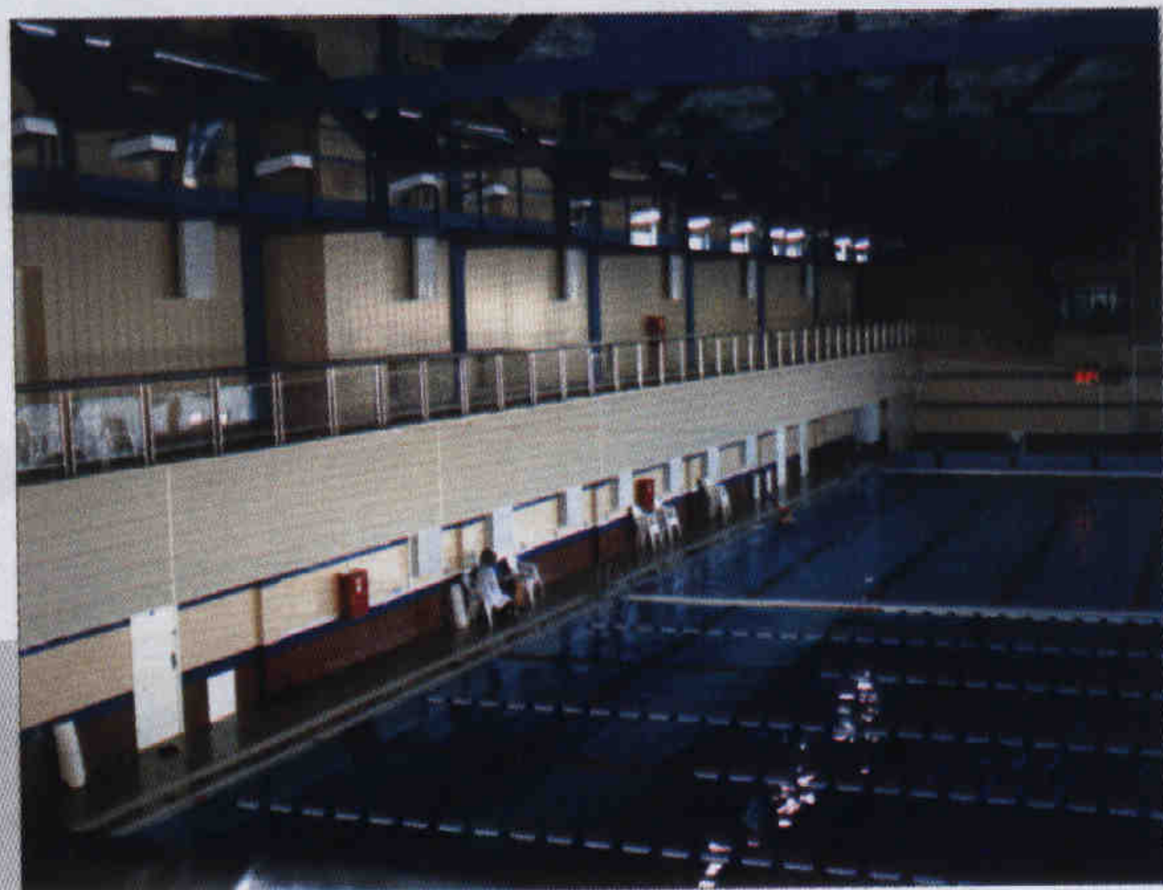
Рис. 3. Помещение плавательного бассейна спортивной школы № 7
