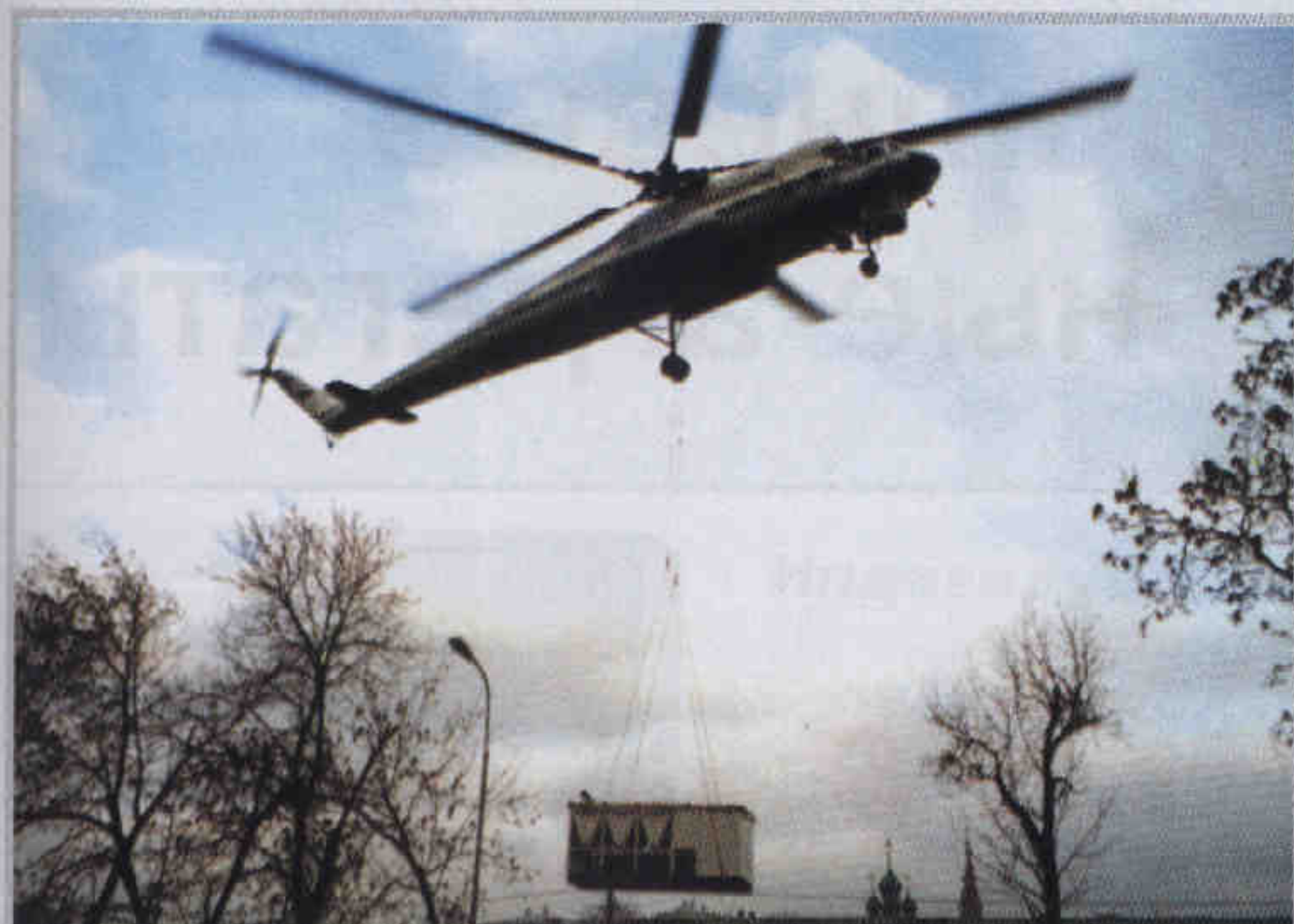
Рис. 3. Транспортирование холодильной машины АСХНР 125 вертолетом к месту монтажа
