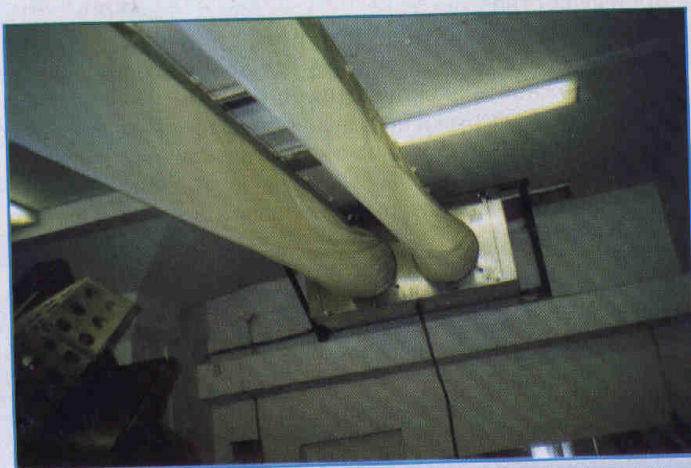
Рис. 1. Тканевые воздуховоды в производственных помещениях Лианозовского колбасного завода (слева) и колбасного завода «Коломенский»
