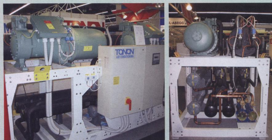
Рис. 4. Чиллеры с компактными компрессорами “Битцер”
