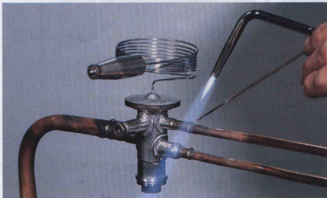
ТС – уникальный терморегулирующий вентиль. Для его пайки не требуется дополнительного охлаждения, что значительно облегчает монтажные работы
