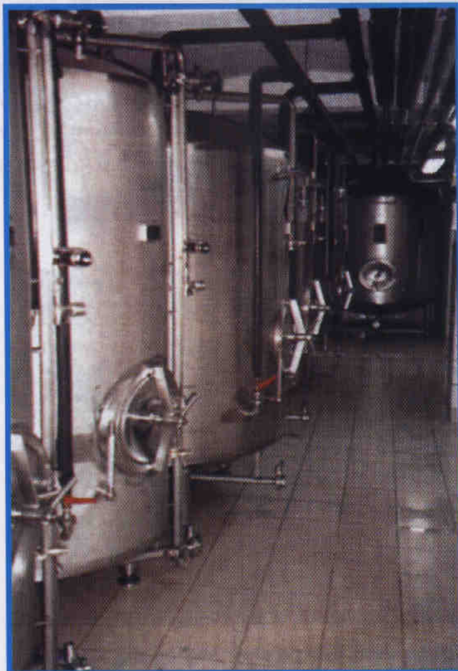
Рис. 1. Бродильное отделение пивоварни в г. Циттау с льдоаккумуляторами
