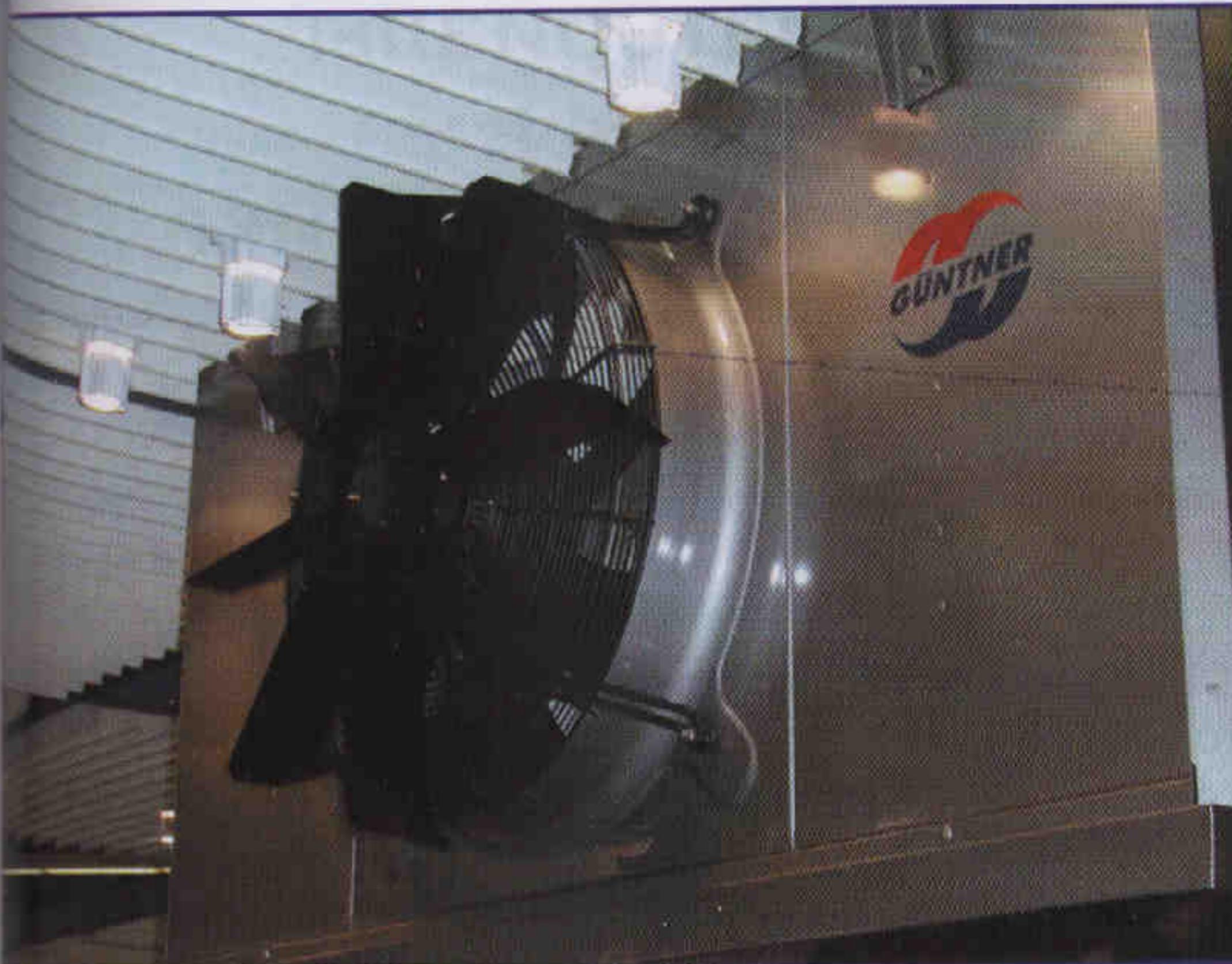
ладителей серии GFH, позволяющие повысить эффективность воздухоохладителя. Специальная форма лопастей насадки позволяет устраниить рассеяние струи и значительно увеличить ее длину, что обеспечивает хорошую циркуляцию воздуха в больших холодильных камерах при сравнительно малых размерах воздухоохладителя.
