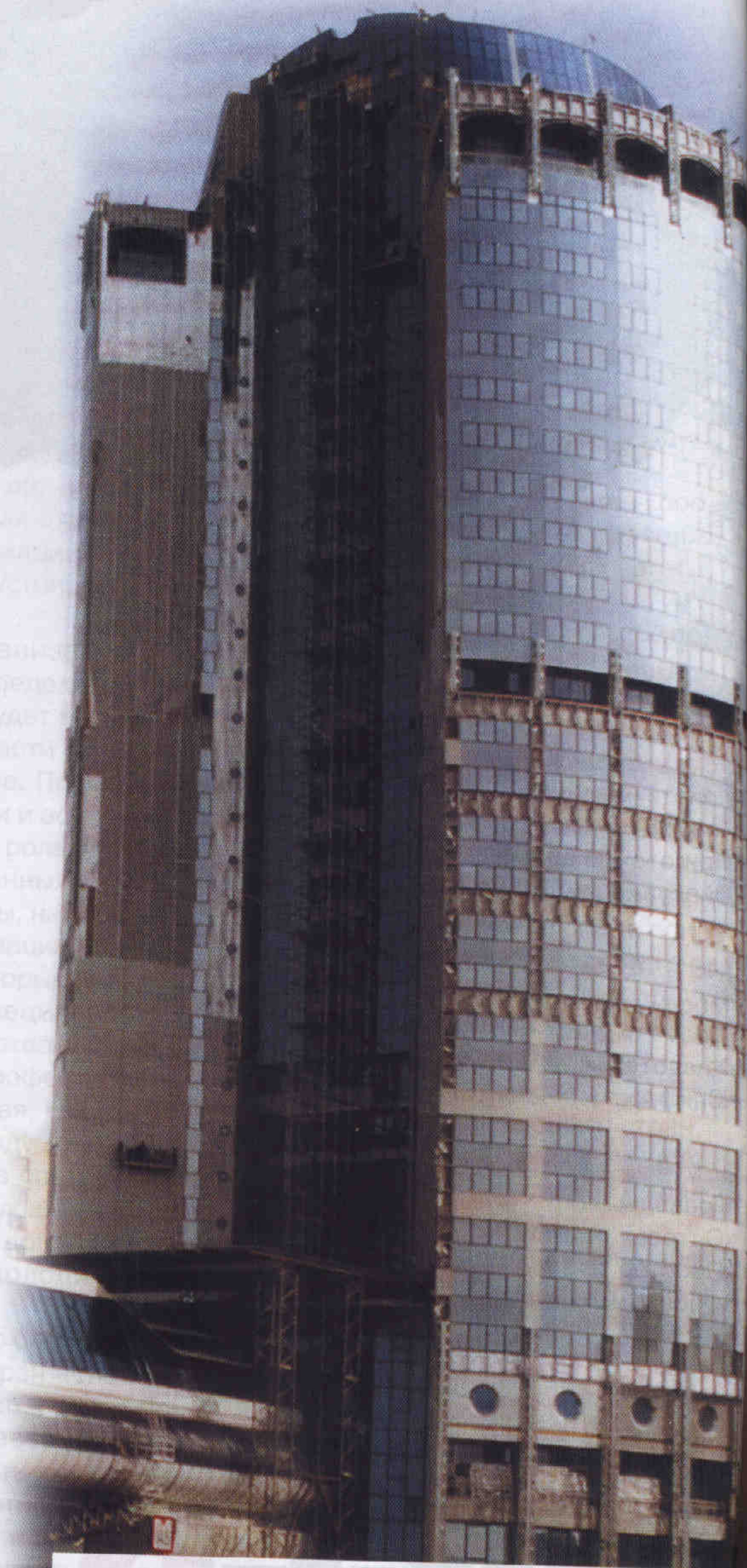
Высотное административно-общественное здание в комплексе «Москва-Сити» с газовой крышной котельной на техническом этаже.
