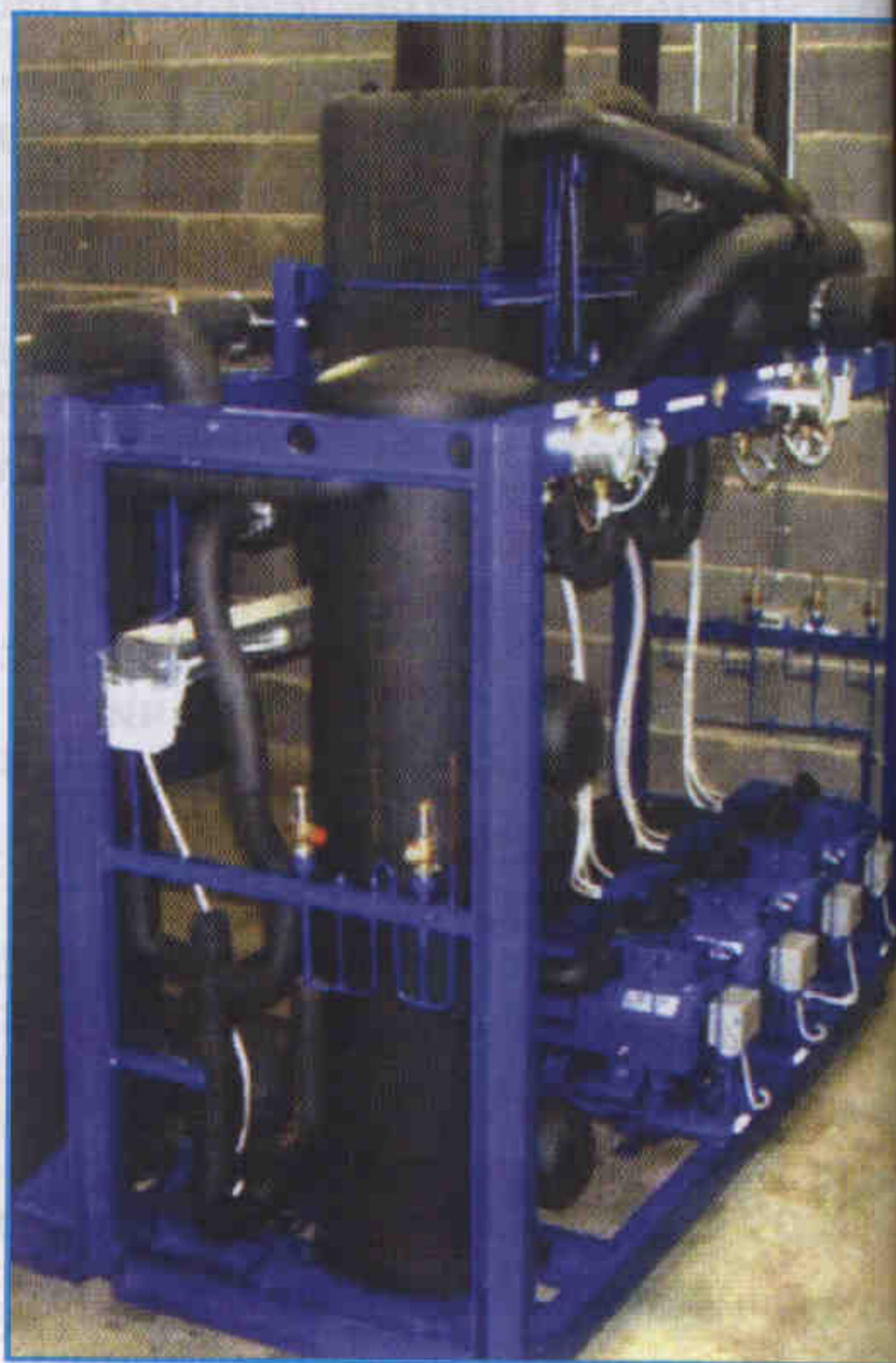
Рис. 1. Многокомпрессорная низкотемпературная установка на CO 2
