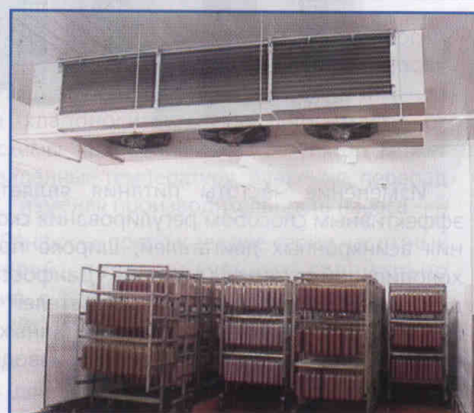
Рис. 5. Камера интенсивного охлаждения колбас
