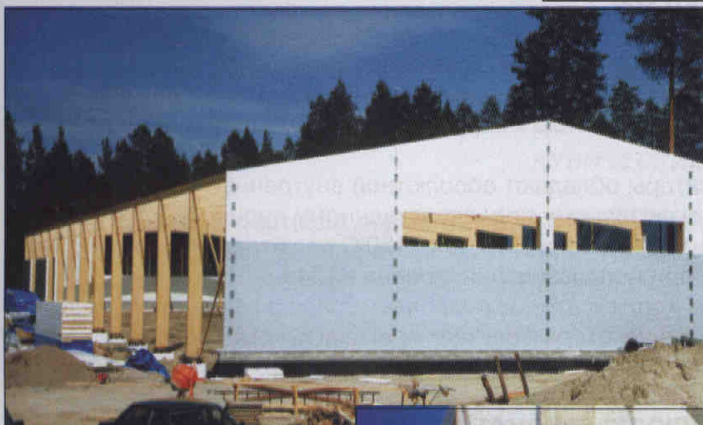
Фото 5. Строительство цеха завода по ремонту холодильного оборудования в г.Ювескюля
