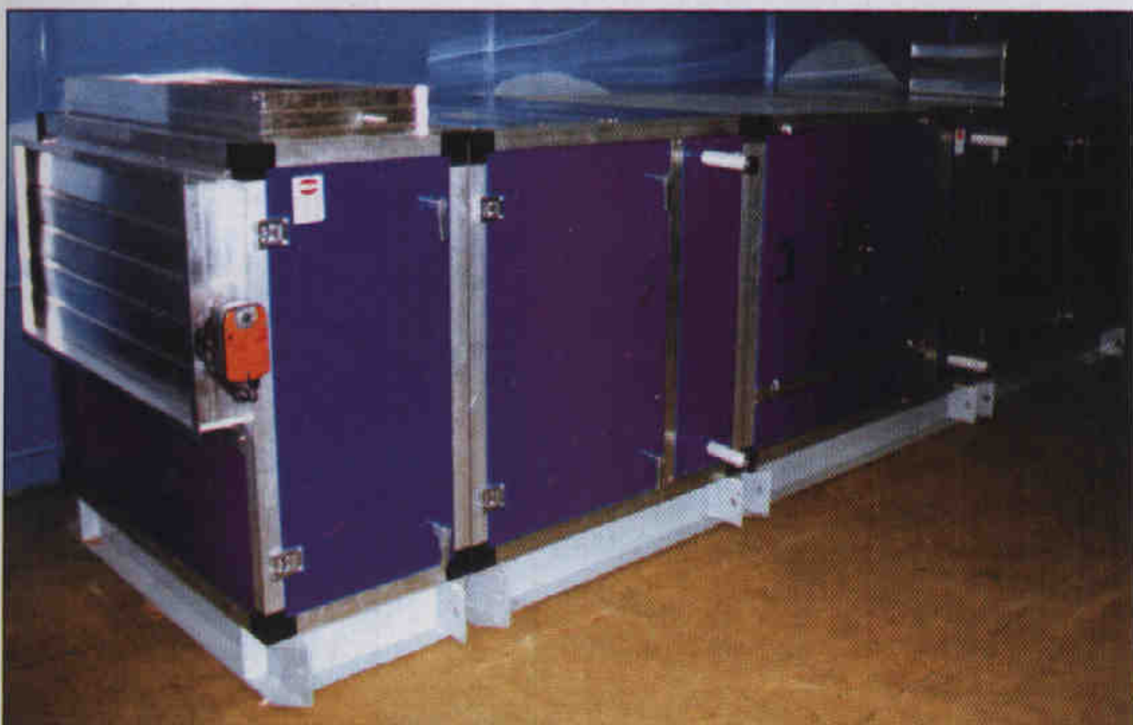
Рис. 1. Центральный кондиционер КЦКП-10 производительностью 8000...15000 м 3 /ч (выпускается с 1997 г.)
