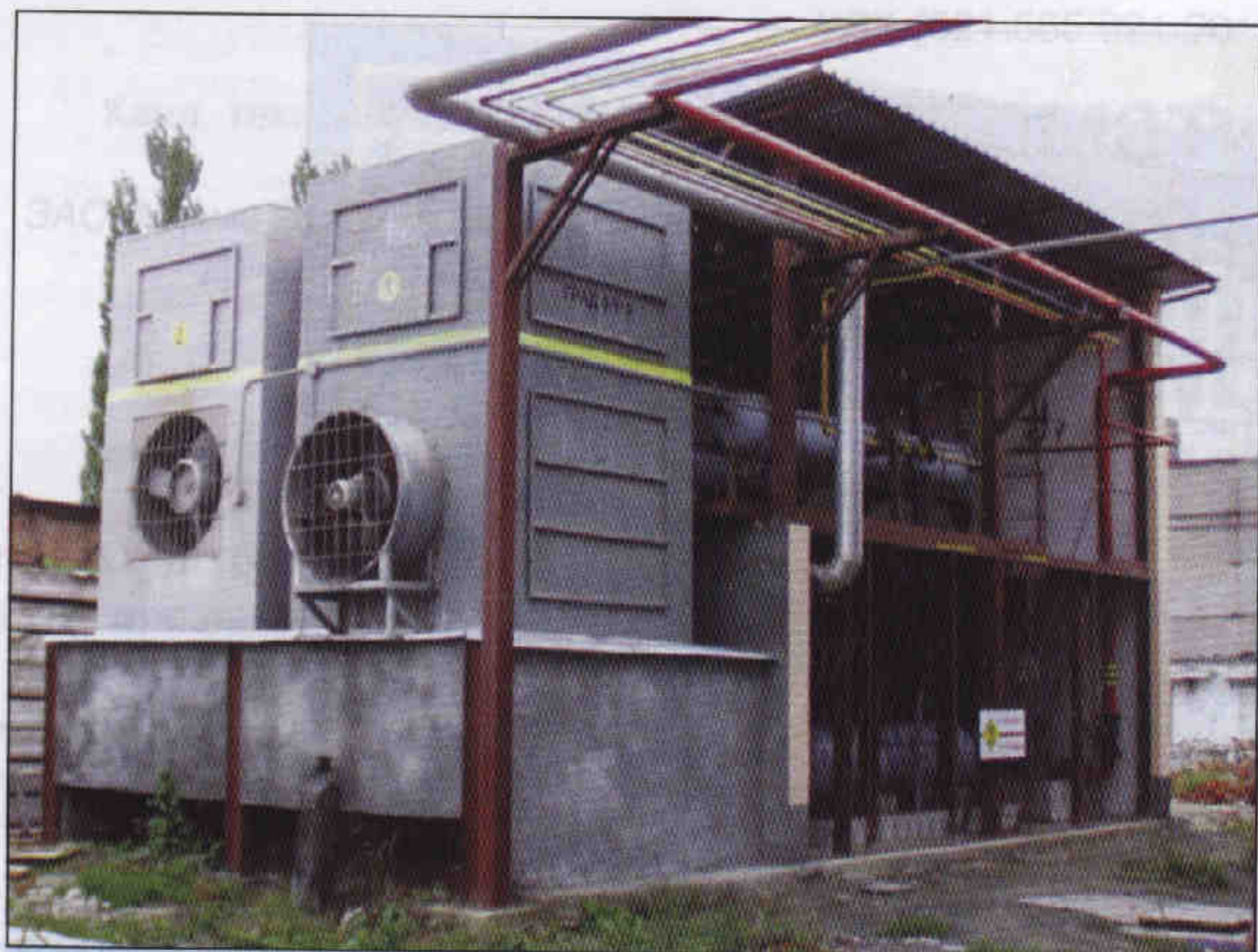
Рис. 6. Общий вид конденсаторного отделения и градирен
