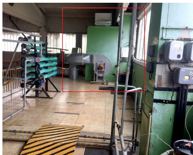
Рис. 3. Внешний вид приточной установки № 1 в защищенном исполнении, которая расположена в машинном зале (зона ИТП) высоковольтной канализационной насосной станции.
