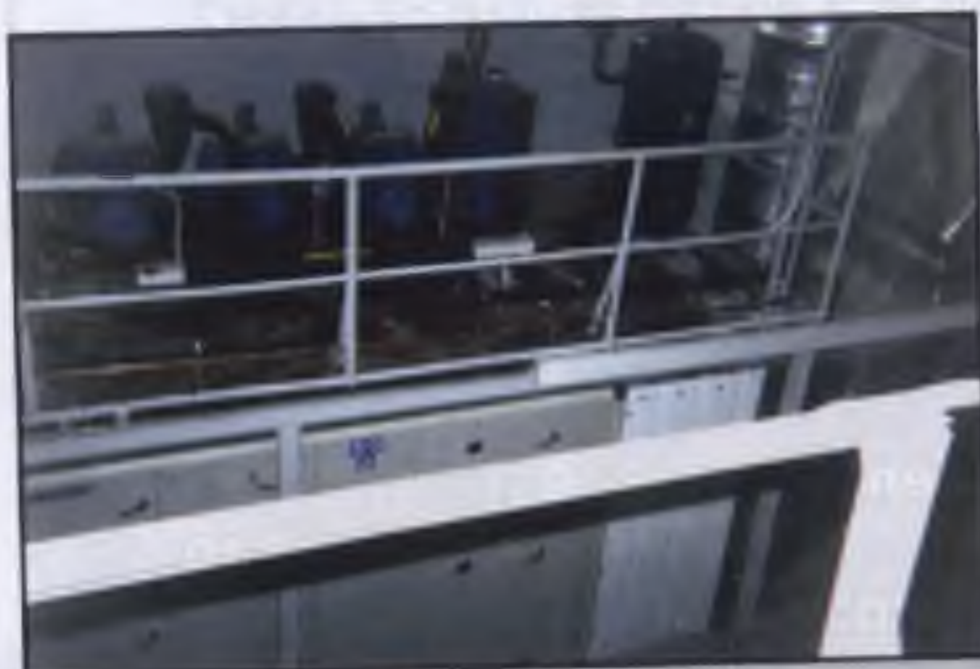
Двухъярусная конструкция с приточно-вытяжной установкой Wesper в нижнем ярусе и холодильной установкой ТЕКО в верхнем
