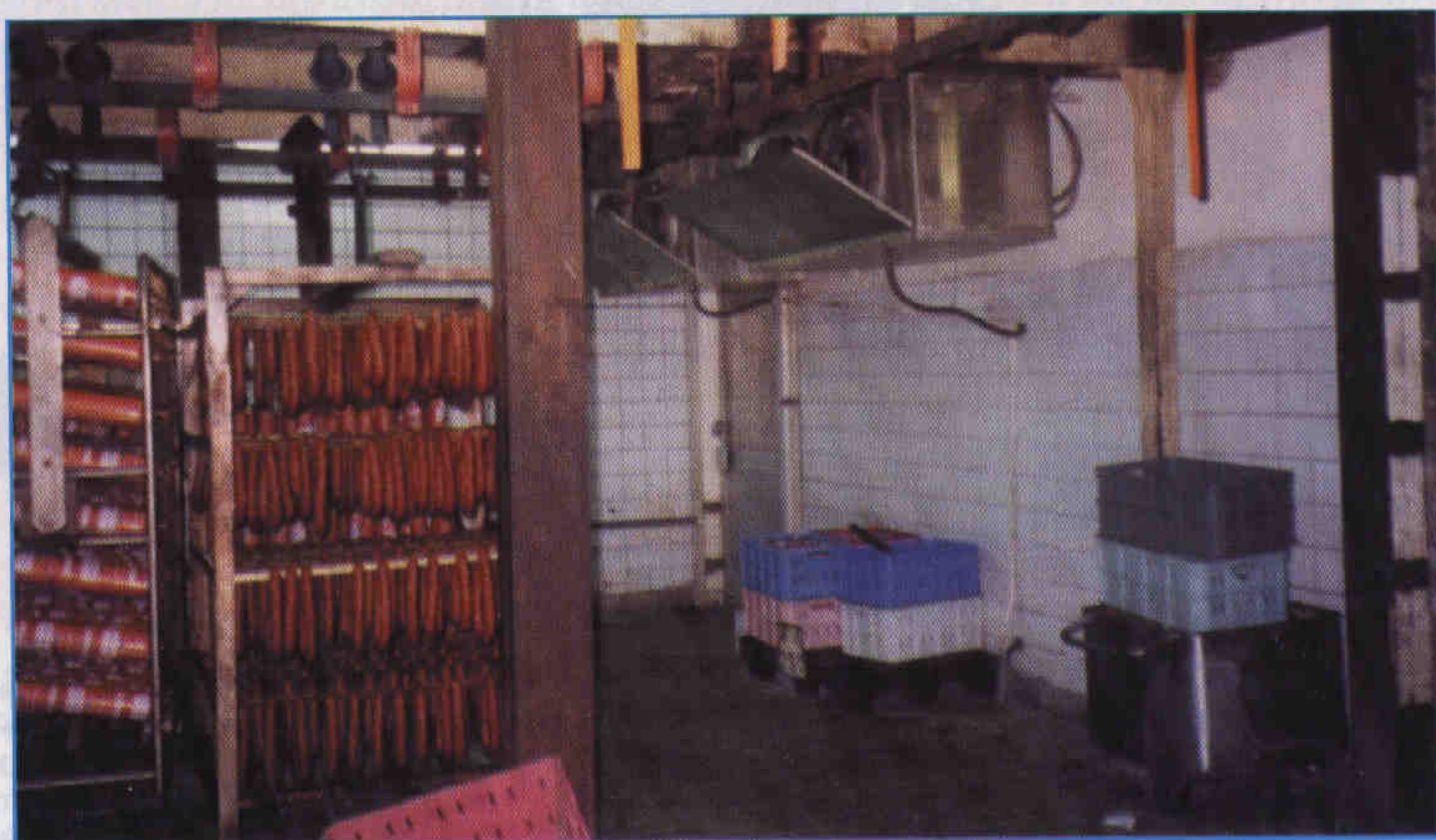
Рис.2. Воздухоохладители с отбойниками в цехе колбасного завода «Коломенский»
