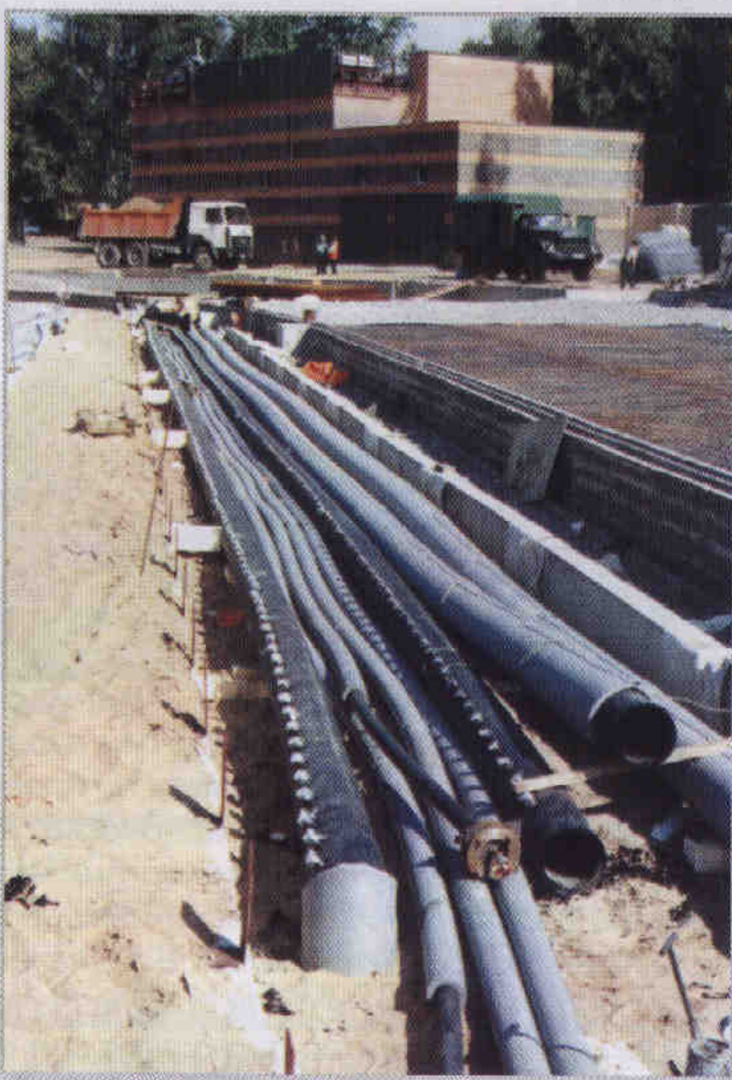
Монтаж магистральных трубопроводов подачи хладагента к полю
