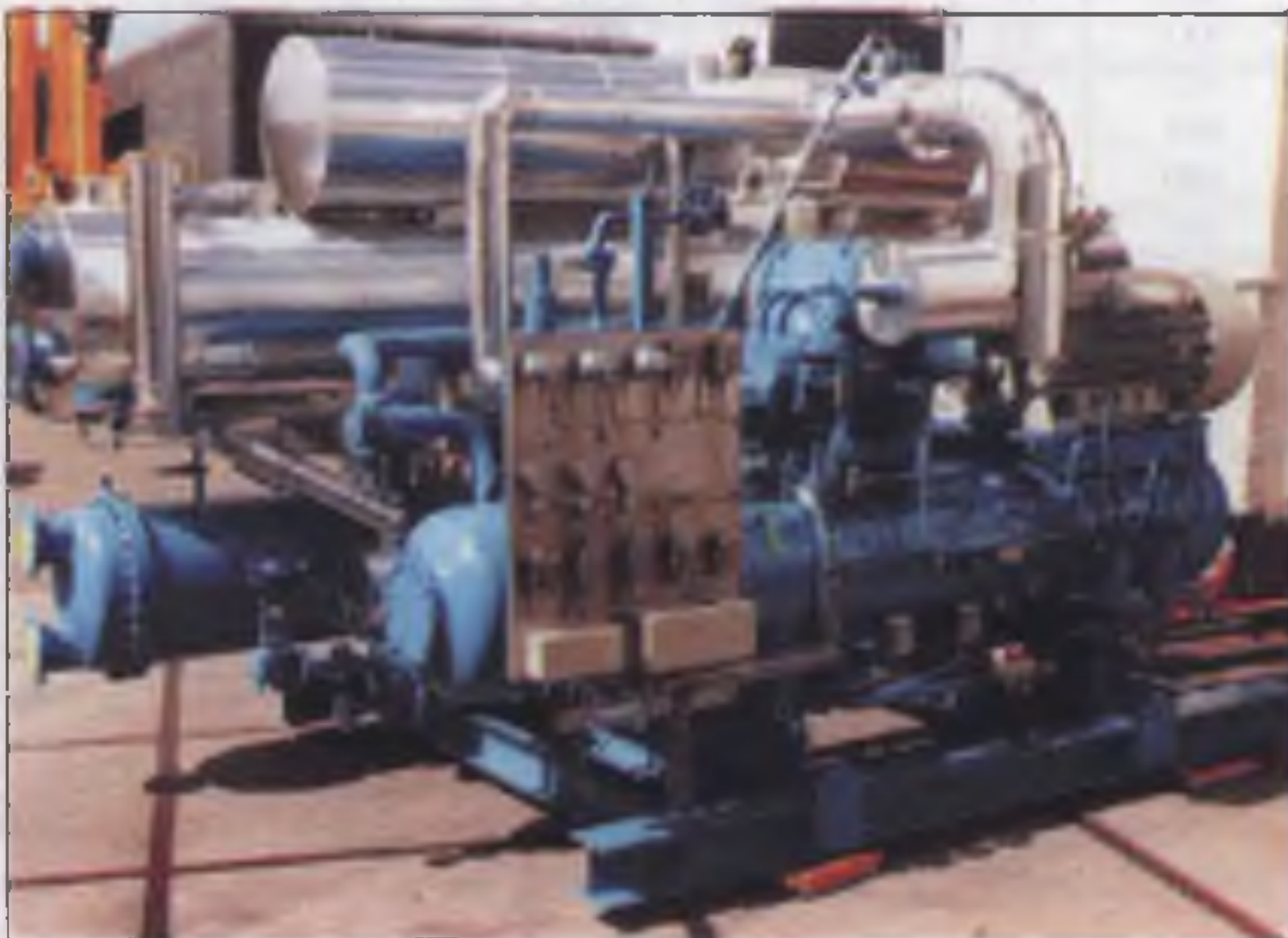
Чиллер на базе винтового компрессора HOWDEN
