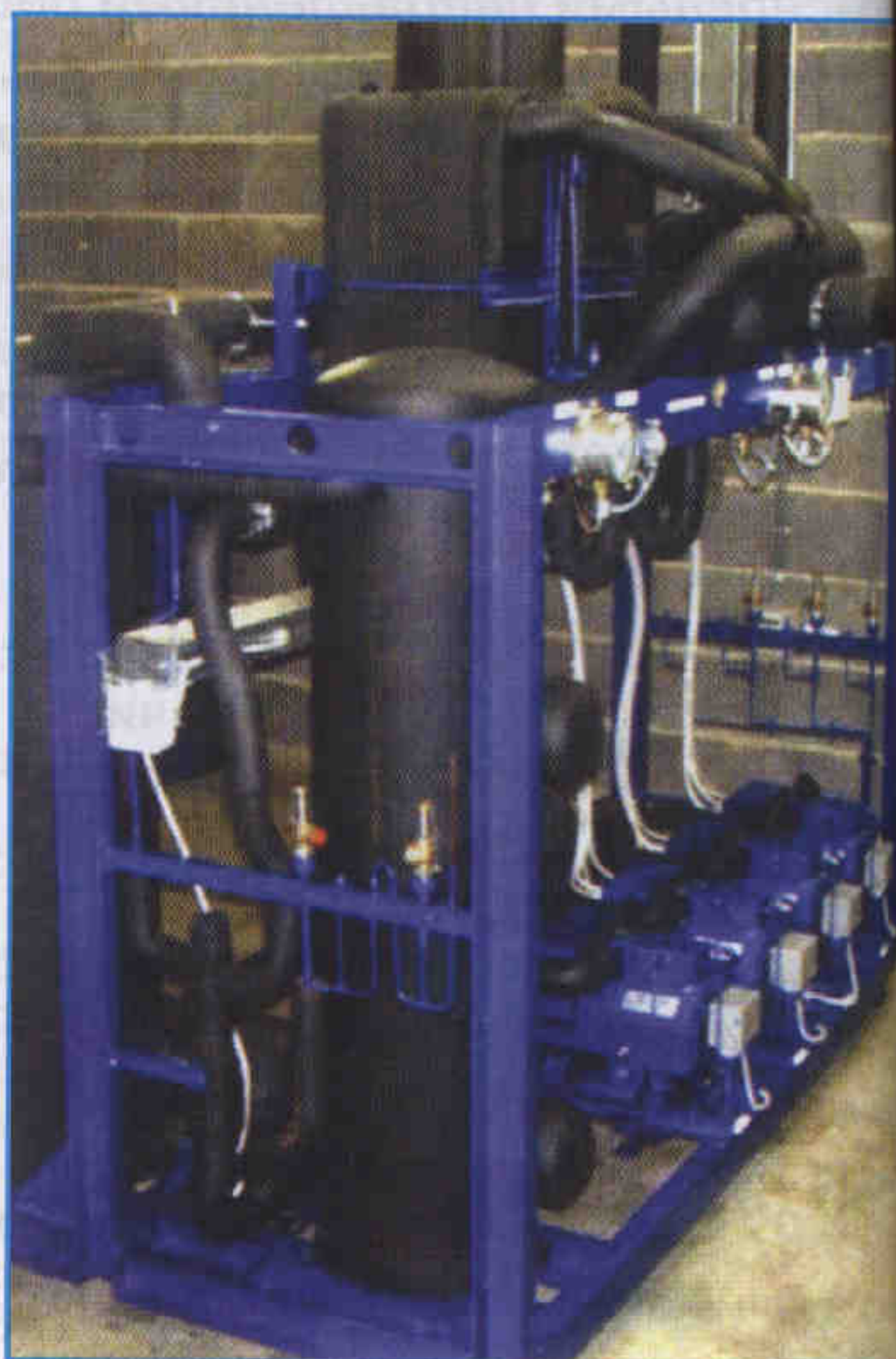
Рис. 1. Многокомпрессорная низкотемпературная установка на CO 2
