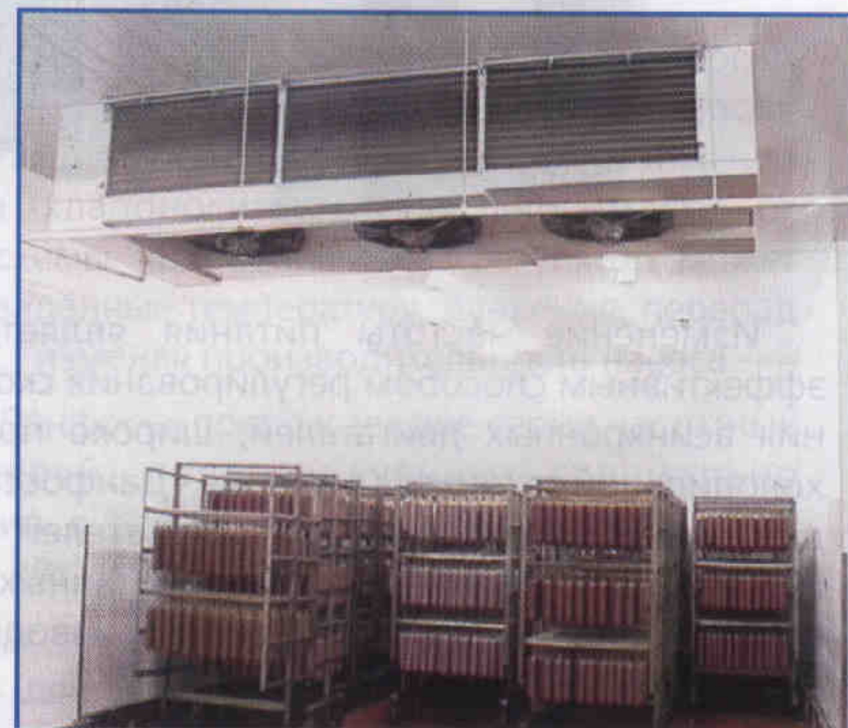
Рис. 5. Камера интенсивного охлаждения колбас
